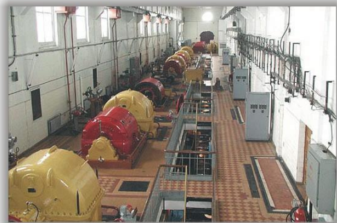
Рисунок 3.3.3. Вид объектов ЦБО КСА. Слева – Аэротенк №3, справа – турбовоздушные агрегаты (ТВА).
