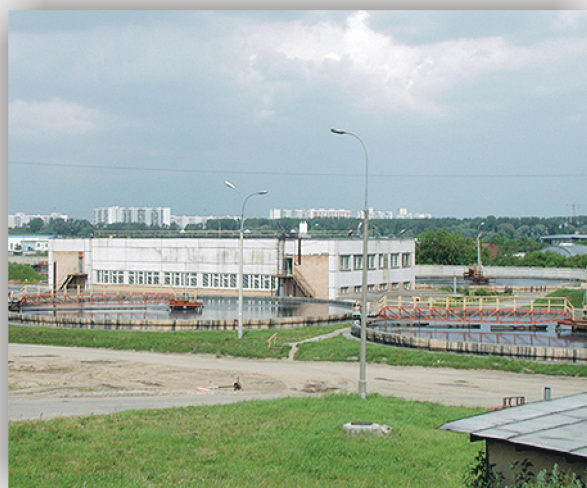
Рисунок 3.4.3. Вид насосной станции №3 ЦМОО КСА.
