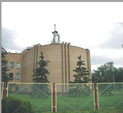
Рисунок 3.1.4. Так выглядят объекты ЦОО КСА. Метантенки.
